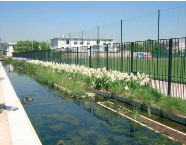
DES BASSINS MAÇONNÉS LONGENT LES TERRAINS DE SPORT.
