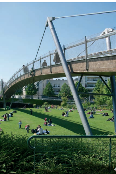
LA PASSERELLE DE LA PROMENADE PLANTÉE - PARIS.
