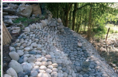
UN MURET DE SOUTÈNEMENT.
